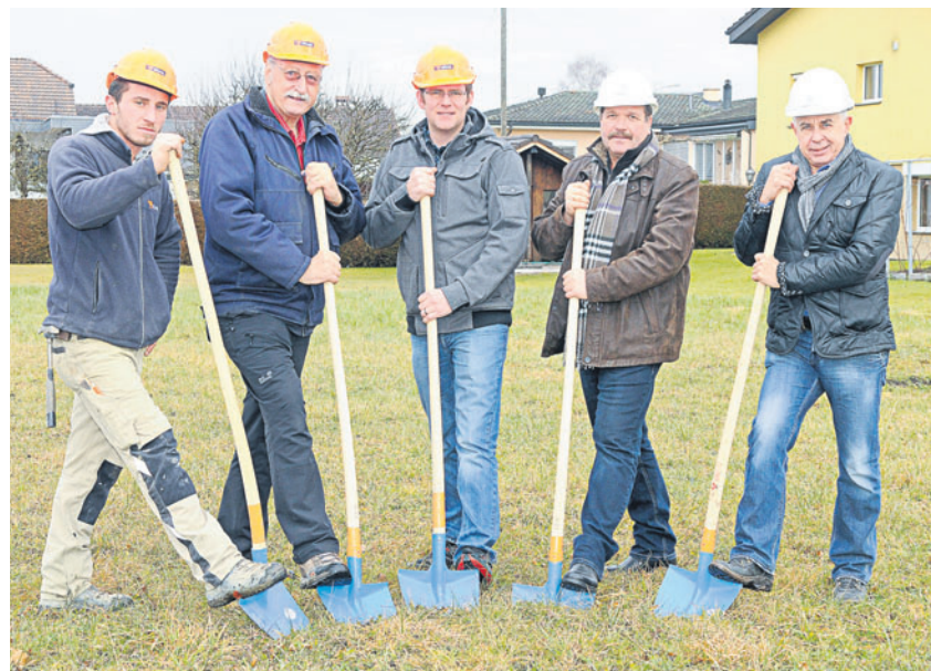
Spatenstich ohne Bagger im Wüerleweg in Ruggell (von links): Hakan Özan, Robert Kohler und Rudi Bollhalder von der Wilhelm Büchel AG sowie Bauleiter Kurt Amann und Werner Heinzle von der Casevere AG. (Foto: Paul Trummer)
